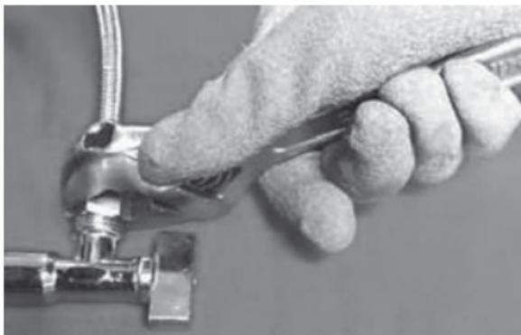
3. EL AJUSTE DEL OTRO EXTREMO DE LA MANGUERA QUE ACOPLA A LA GRIFERÍA DEBE SER A MANO SOLAMENTE **(NO USAR HERRAMIENTA)**.
